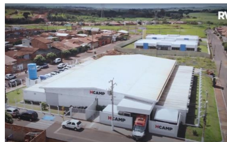
Figura 1. Hospital de Campanha de Rio Verde – GO
